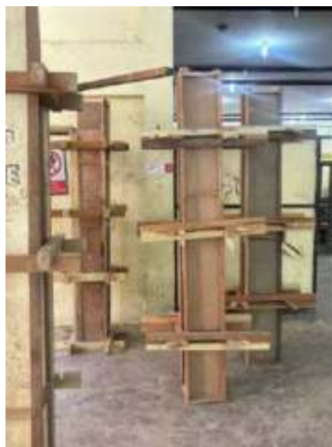
Gambar 23. Bekisting Kolom
